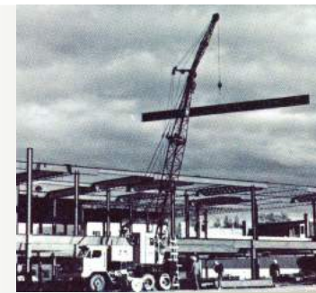
Installation de charpentes d'acier
